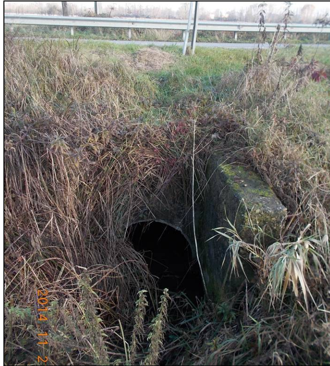
Figura D- 5. Attraversamento costituito da un condotto in calcestruzzo Ø 800 mm (vista da monte verso valle) in grado di convogliare fino a 0.6 m 3 /s.
