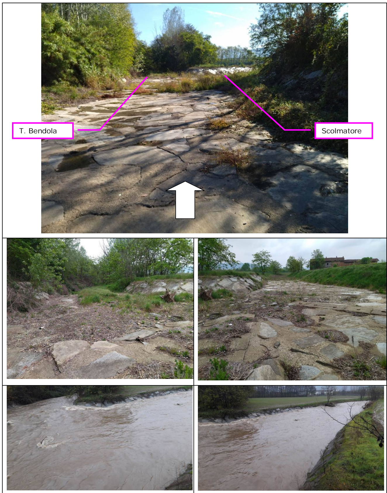
Figura 2-17. Riprese (da monte verso valle) dell'imbocco del canale scolmatore (a sinistra il T. Bendola, a destra il canale scolmatore). Le immagini della piena sono riferite all'evento nell'autunno 2019 (in quell'occasione non si sono registrati inconvenienti nel tratto cittadino).
