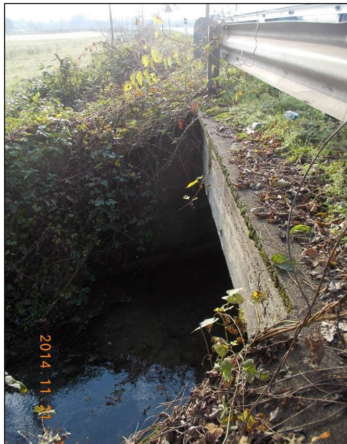
Figura D- 6. Attraversamento costituito da uno scatolare 3x1.2 (vista da valle) in grado di convogliare fino a 7 m 3 /s circa.
